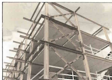
Woongebouw in Friuli: gedeeltelijk zicht van de structuur met prefab betonvloeren.
