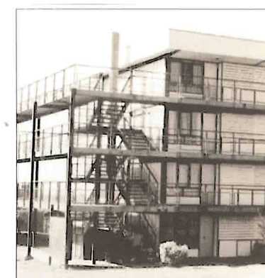
Paraseïsmisch gebouw in Chili
