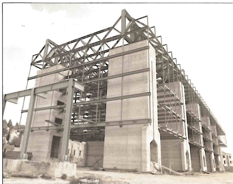
Nieuwe brandweerkazerne in Napels: met het oog grote ruimte op het gelijkvloers vrij te maken, werd de structuur van de bovenverdiepingen opgehangen aan een stalen raster door gewapend beton torens ondersteund.
