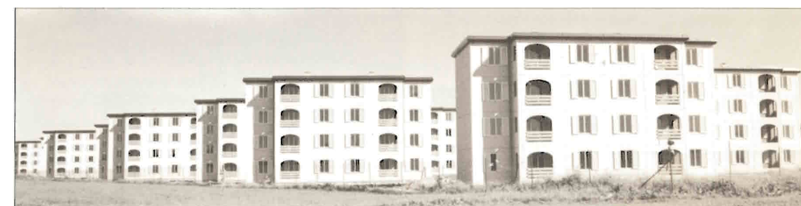
Paraseïsmische woningen - Algerië
