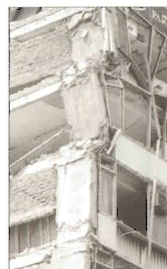
Verbindingsbreuk en afsplintering.
