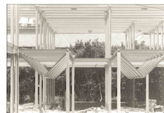
School met stalen draagconstructie in Italië
